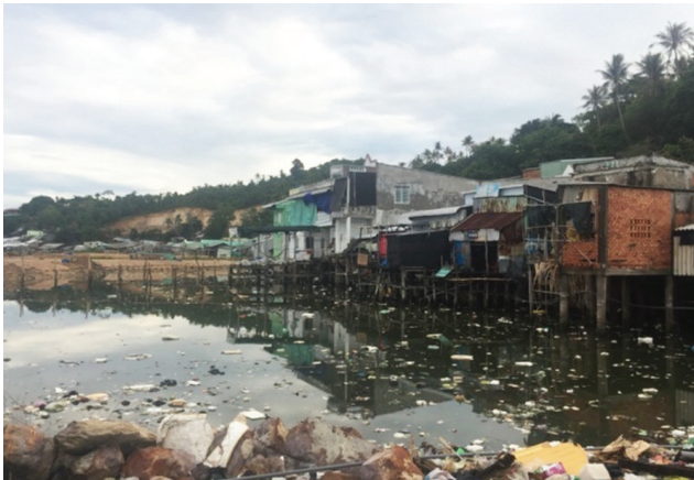
Hệ thống nước thải năm 6/2020
